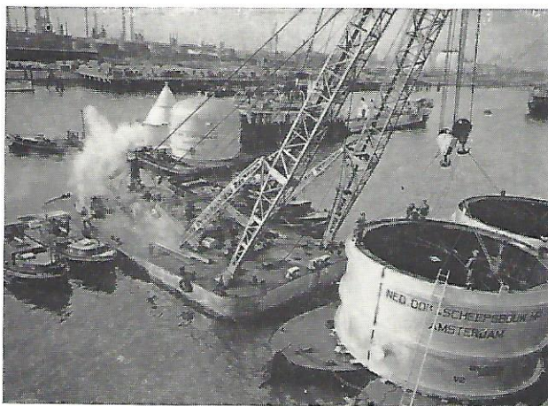
Aanvoer van materiaal over water.
